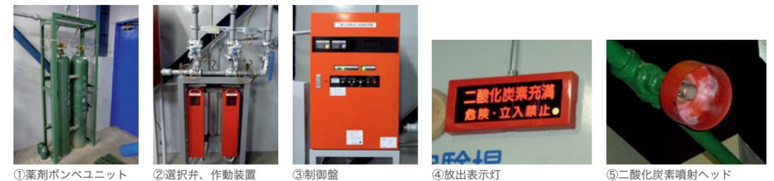
①薬剤ボンベユニット ②選択弁、作動装置 ③制御盤 ④放出表示灯 ⑤二酸化炭素噴射ヘッド
